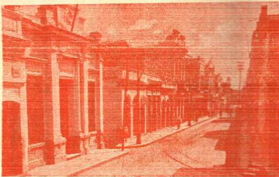
TRECHO DA RUA MACIEL PINHEIRO
