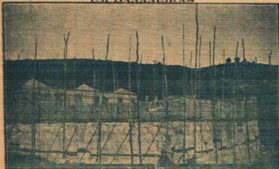
Patronato agrícola "Vidal de Negreiros", em construção.
