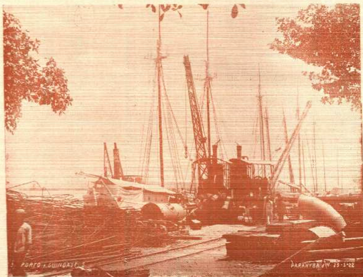
CONSTRUÇÃO DE ESTACAS DE CONCRETO ARMADO PARA O CAIS
