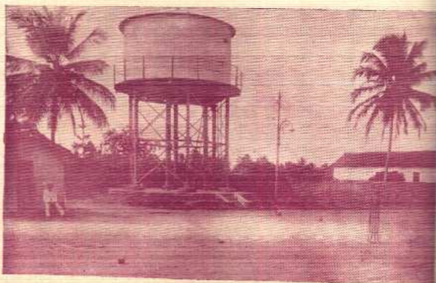
RESERVATORIO DA AGUA NA AVENIDA JOÃO MACHADO
