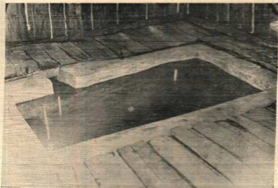
5) TANQUE NO INTERIOR DA CASERNA AZEVA
