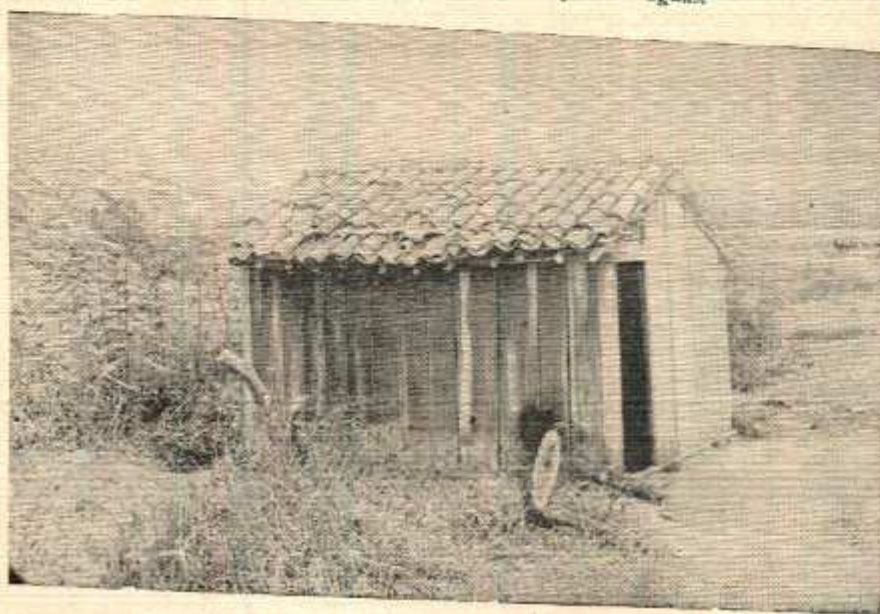
4) PEQUENA CASA QUE ABRIA UMAS DAS FONTES THERMAES
