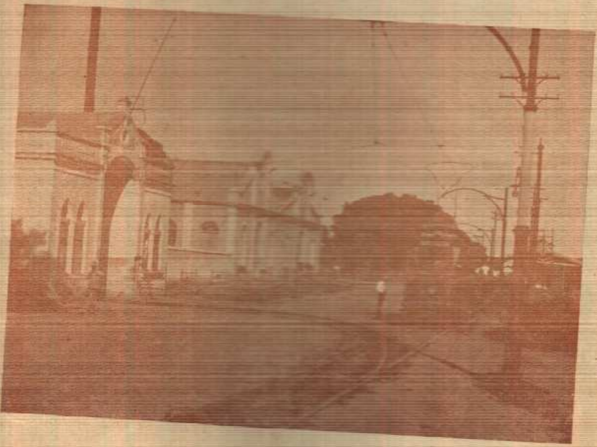
CASA ELECTRICA DA T. L. & F.
