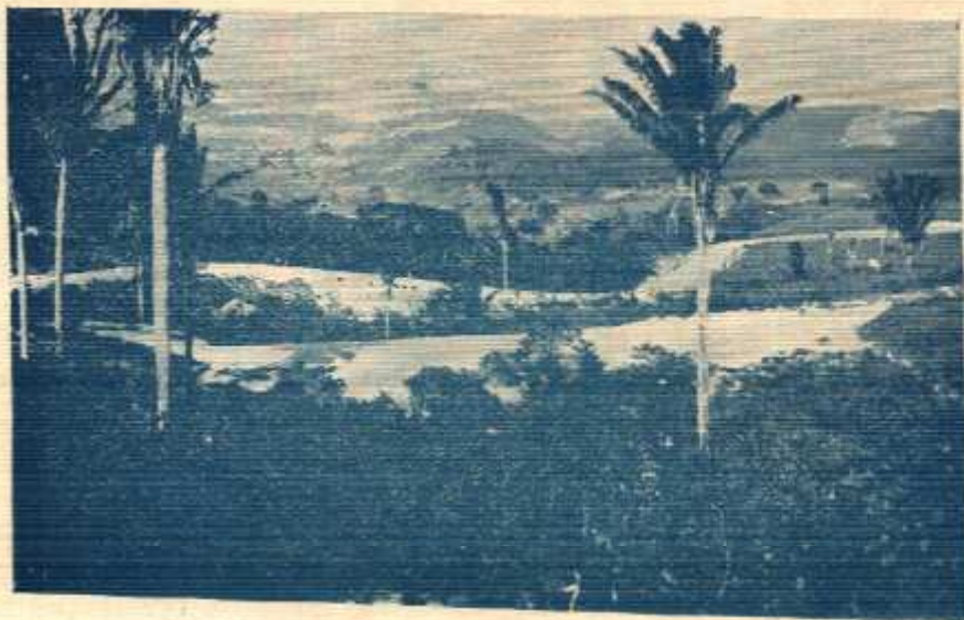
ESTRADA DE RODAGEM DE BOBBOREMA A SERRARIA
