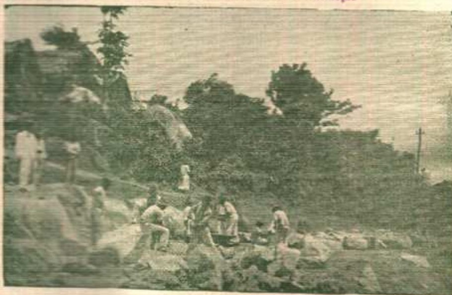
ESTRADA DE BANANEIRAS A MORENO — Trecho em construção
