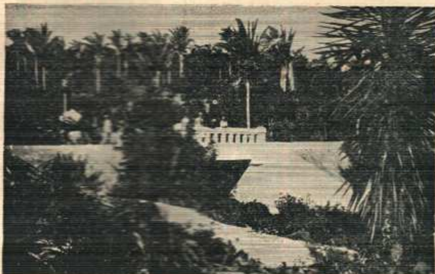
ESTRADA DE RÓDAGEM DE BORBOREMA A SERRARIA — Pontilho sobre o rio RONGADOR
