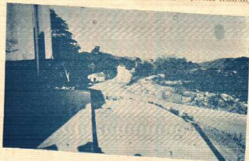
ESTRADA DE RODAGEM DE BOBBOREMA A SERRARIA
