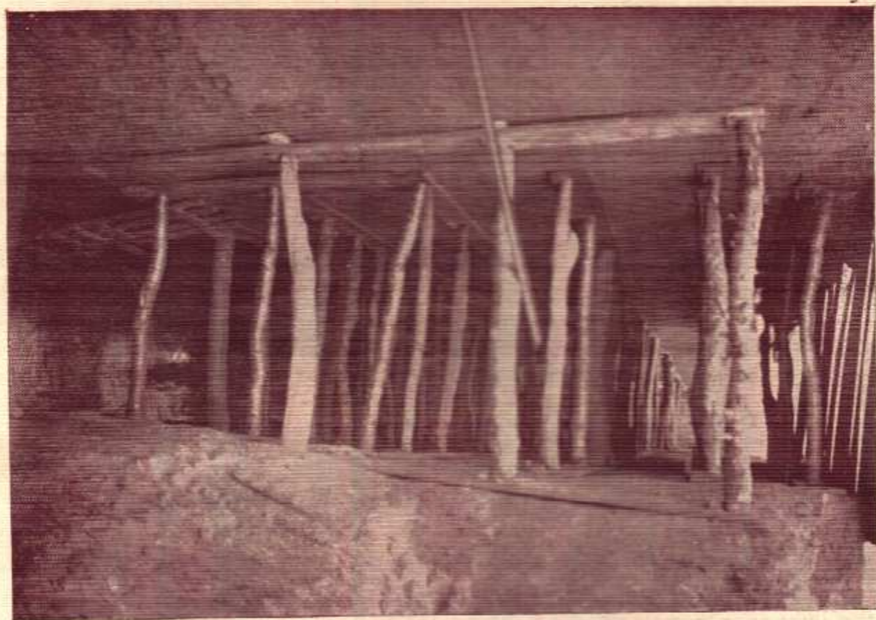
AÇUDE NEGRINHOS — Escoramento da cave do núcleo
