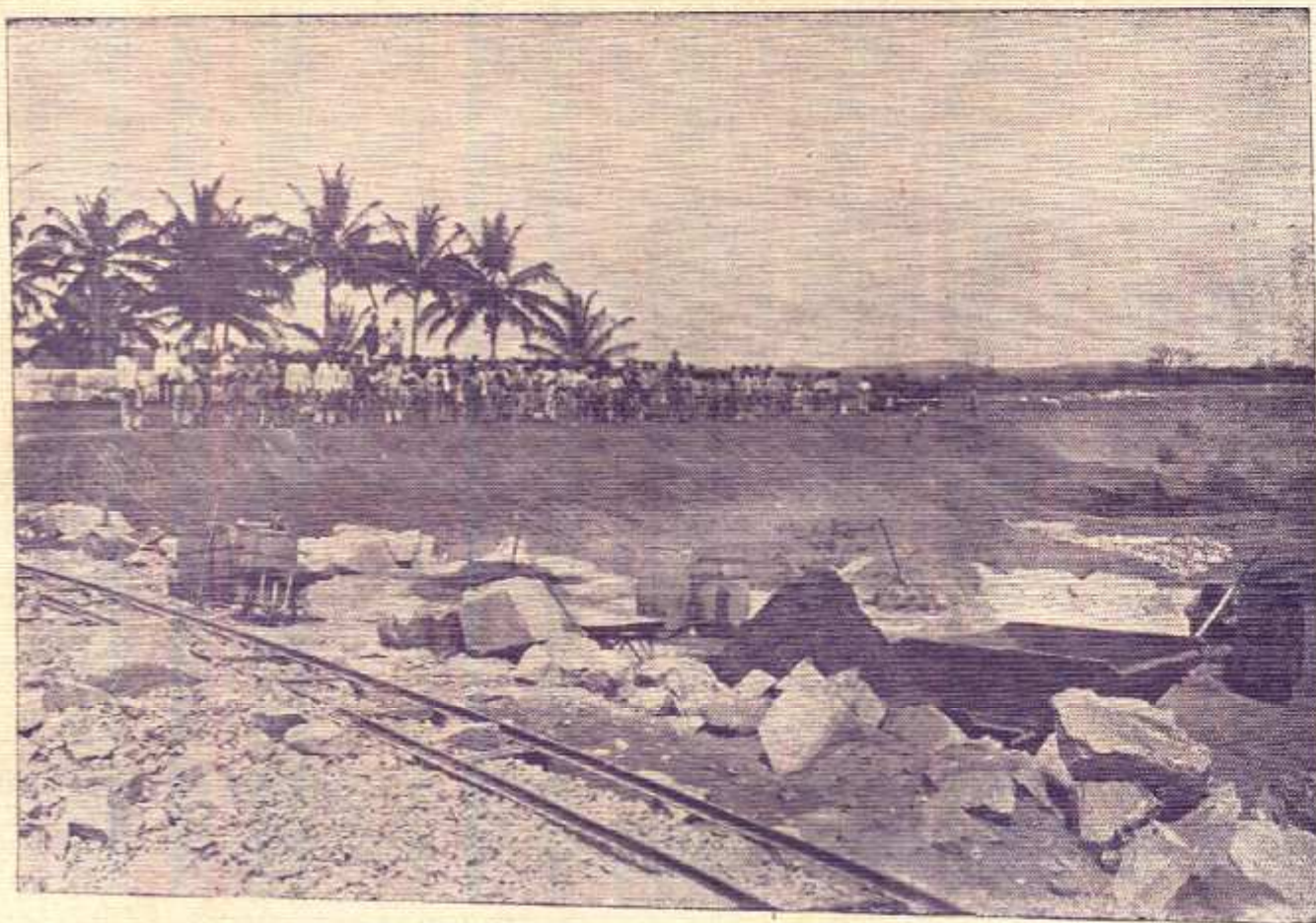
AÇUDE NEGRINHOS — Pessoal empregado na construção
