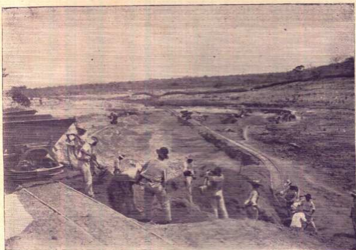
AÇUDE NEGRINHOS — Escavação em material silico-argiloso para a construção da barragem
