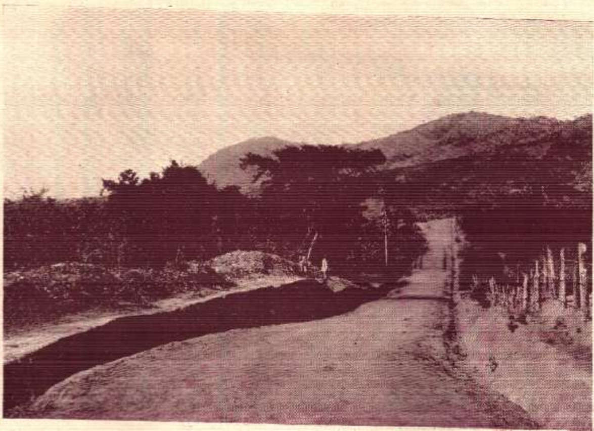
ESTRADA DE RODAGEM DE ALAGOINHA A ALAGOA GRANDE — Fazenda S. Antonio
