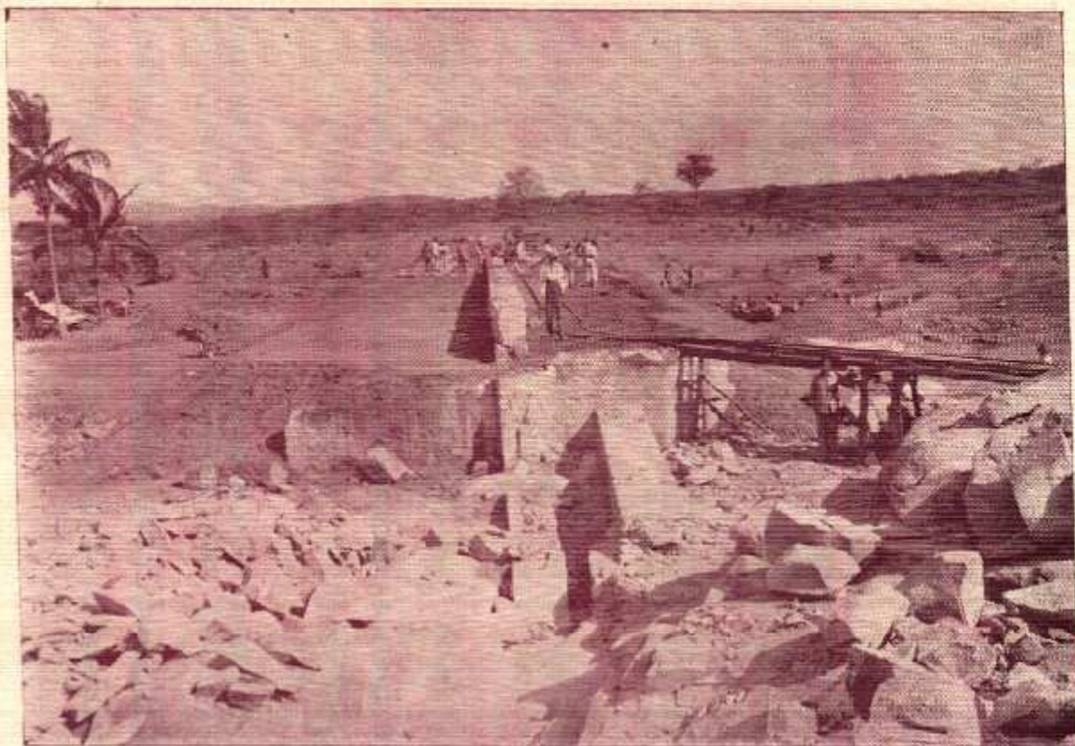
AÇUDE NEGRINHOS — Vista geral do núcleo de alvenaria
