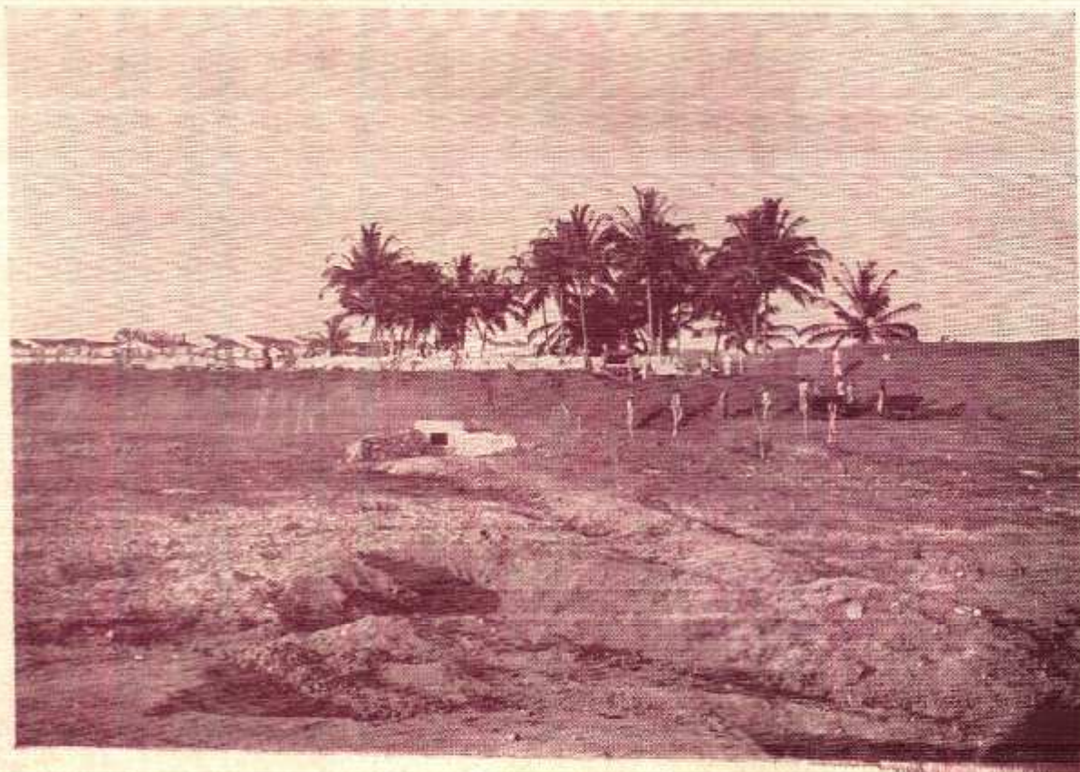
AÇUDE NEGRINHOS — Galeria de descarga e torre de tomada d'água
