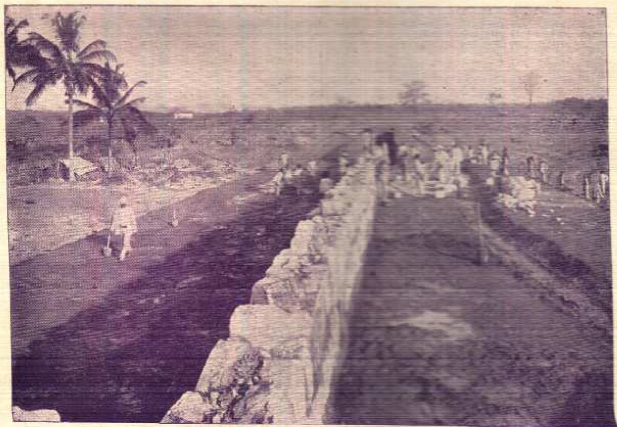
AÇUDE NEGRINHOS — Avançamento da seção central e barragem
