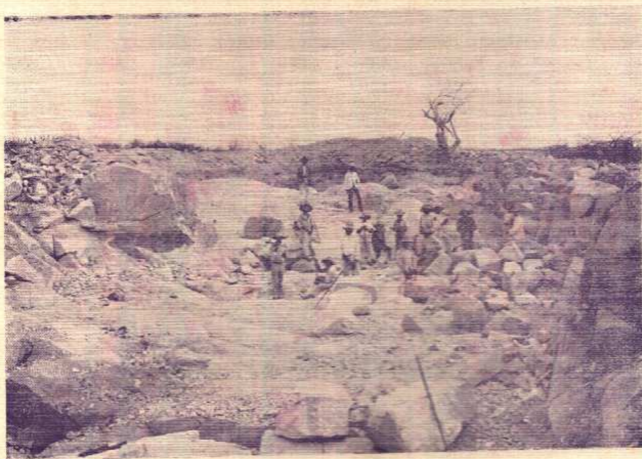
AÇUDE NEGRINHOS — Desmonte de pedra para a construção do núcleo de alvenaria
