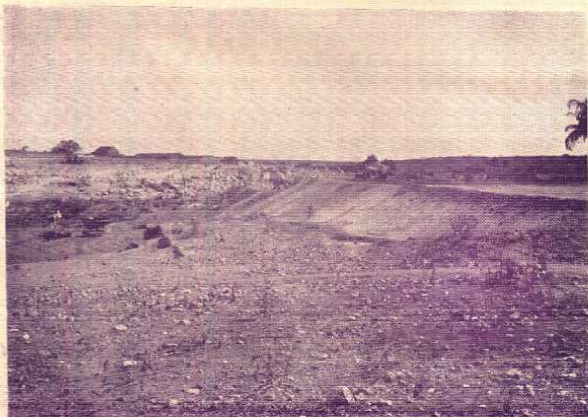
— AÇUDE NEGRINHOS — Barragem. Vista do montante
