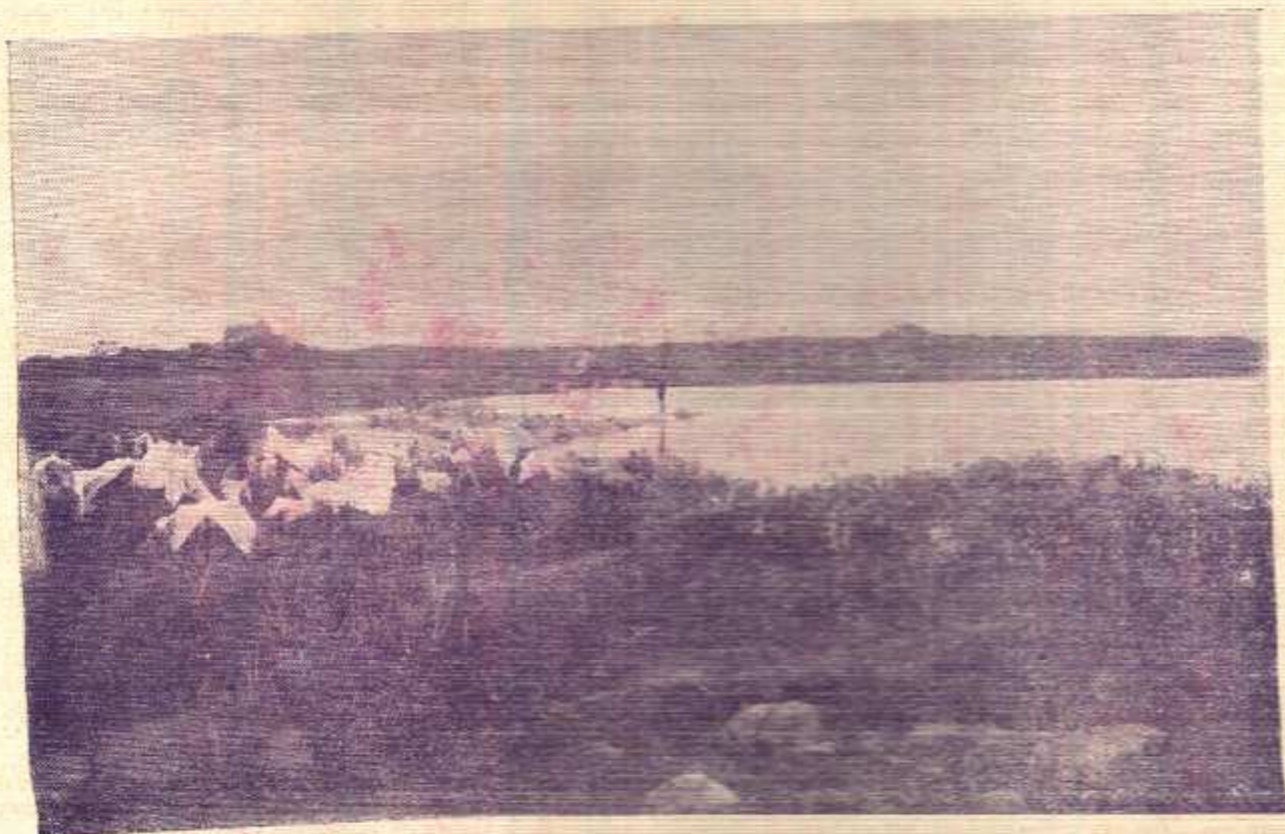
AÇUDE NEGRINHOS — Barragem. Vista do montante
