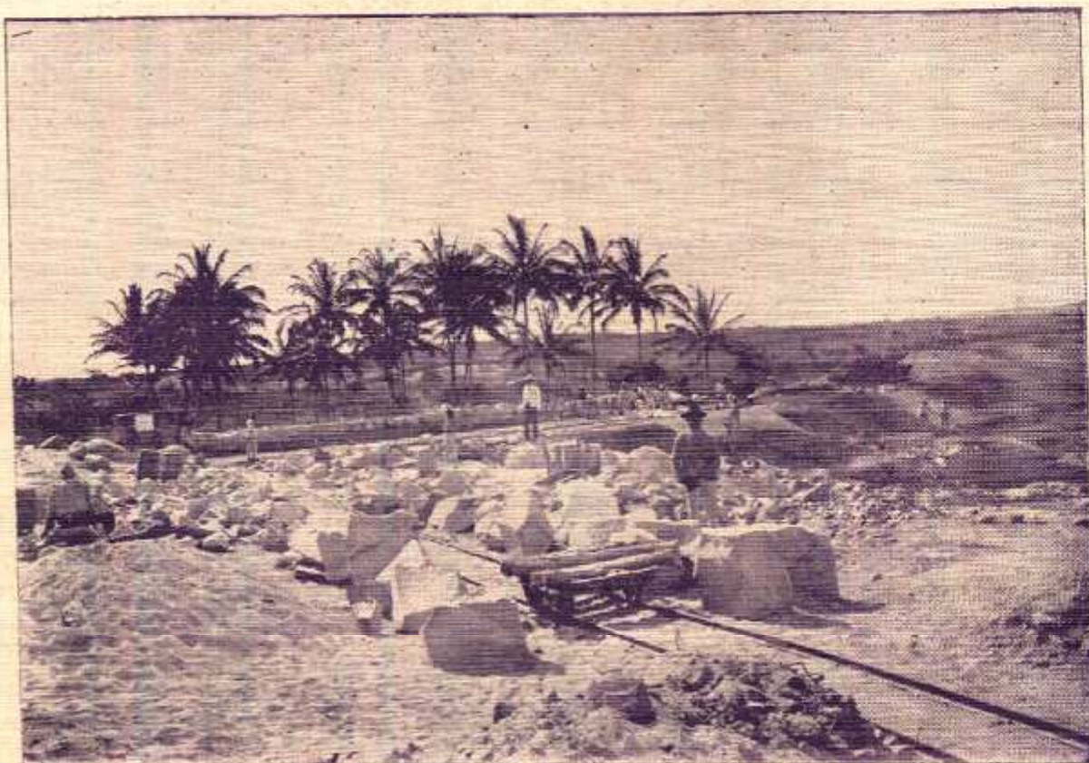
AÇUDE NEGRINHOS — Vista do montante, da barragem e do núcleo
