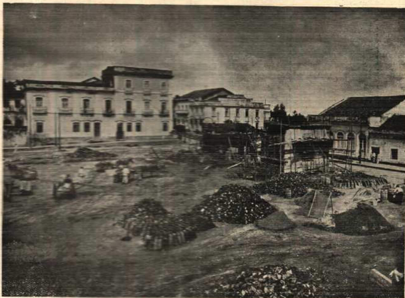
Durante os trabalhos de construção da Praça Vidal de Negreiros.
