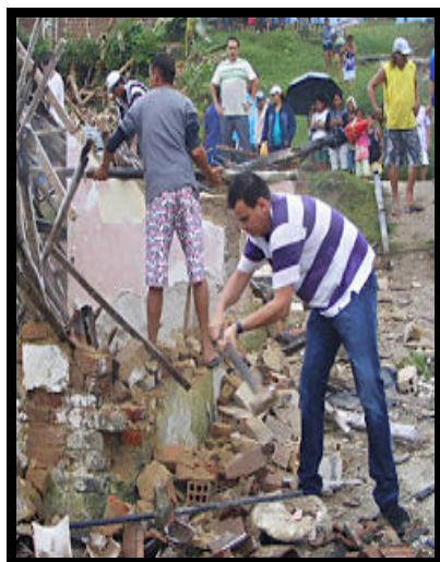
Figura 9 – Radialista participa da demolição da casa da família chacinada. https://goo.gl/DNd1hz ; acesso em 7/7/15.
