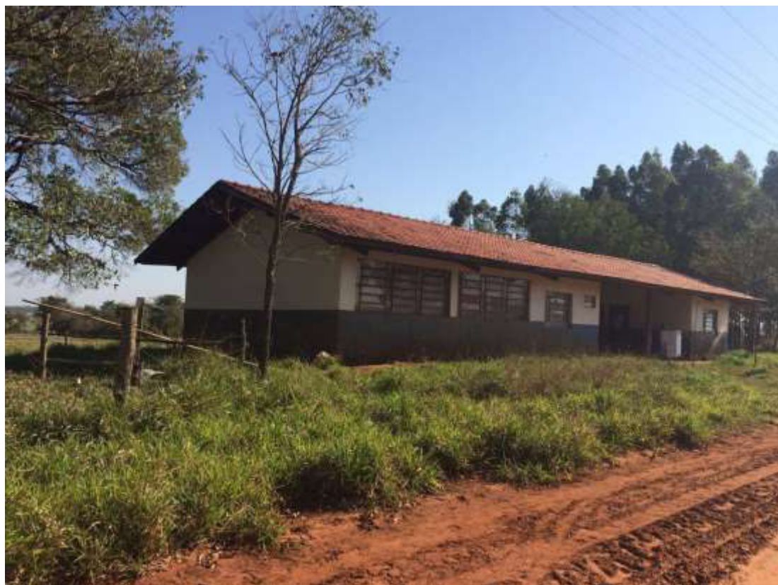
Figura 1: Estrutura onde funcionou a escola João Batista, atualmente funciona como cooperativa de leite da comunidade. Registro de 2016.
